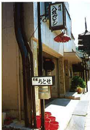
S字に曲げて目立たなくした電柱
